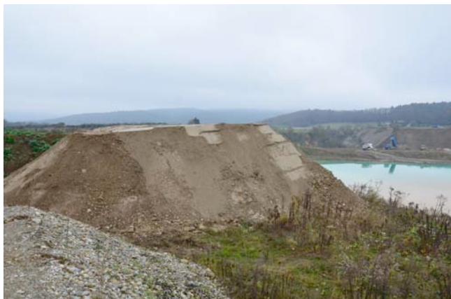
Neu gebauter Sandhügel für die Uferschwalben in der Kiesgrube Hildenbrand, vor dem Abstechen im Frühjahr 2015.
