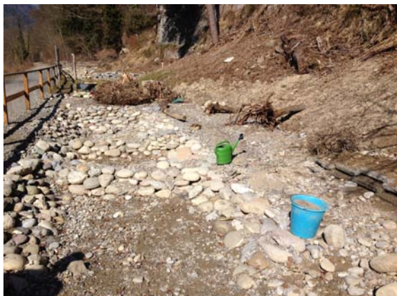
Bau der Strukturen um den neuen Weiher bei Rüschlikon.
