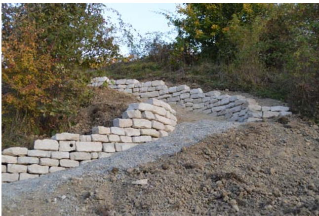
Trockensteinmauer und Wegserpentine „Im Alten Wingert“. In der Trockensteinmauer ist eine Wiedehopf Nisthilfe eingebaut.
