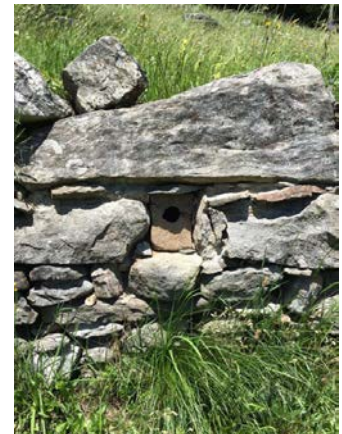
Sanierte Trockensteinmauern in der Terrassenlandschaft Mergoscias, sowie darin integrierte Wiedehopf-Nisthilfe
