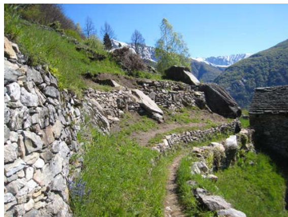
Sanierte Trockensteinmauern in der Terrassenlandschaft Mergoscias, sowie darin integrierte Wiedehopf-Nisthilfe
