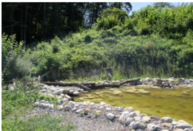
Neu gebauter Ablassweiher im Wehntal im Sommer 2016.
