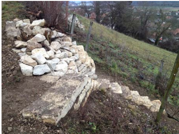
Die sanierte Steintreppe mit kleiner Trockensteinmauer im Schlossberg Villigen.
