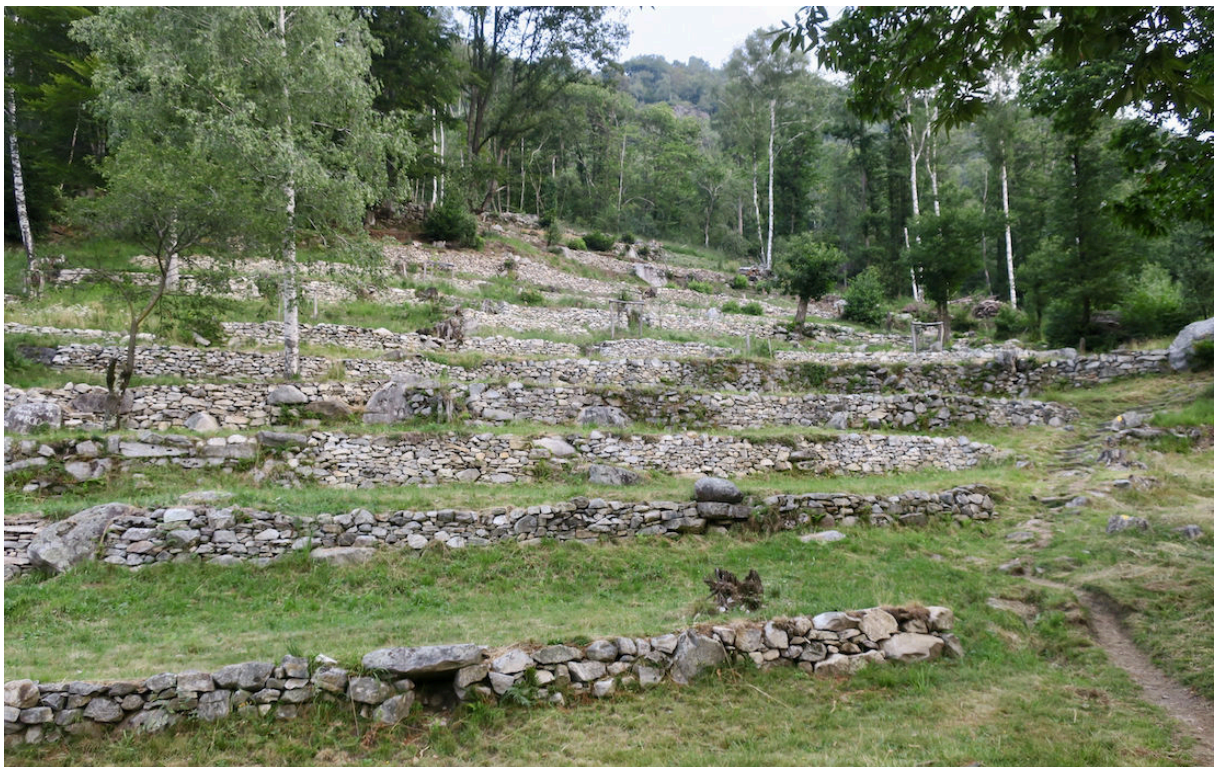
Fertig sanierte Terrassen von «Campelia dressa» (Foto U. Nüesch).
