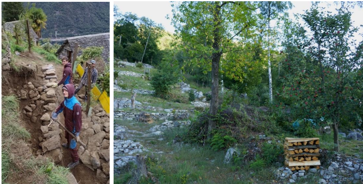
Links: Zivildienstleistende bei der Sanierung von Trockenmauern im «vite maritata» Rebberg. Rechts: Vielfältig strukturierter Übergang von rekultivierter Terrassenlandschaft links in Lichten Wald. Grosser Asthaufen in der Bildmitte, Brennholzbeige, Mehlbeere und Lesesteinhaufen (Fotos U. Nüesch).
