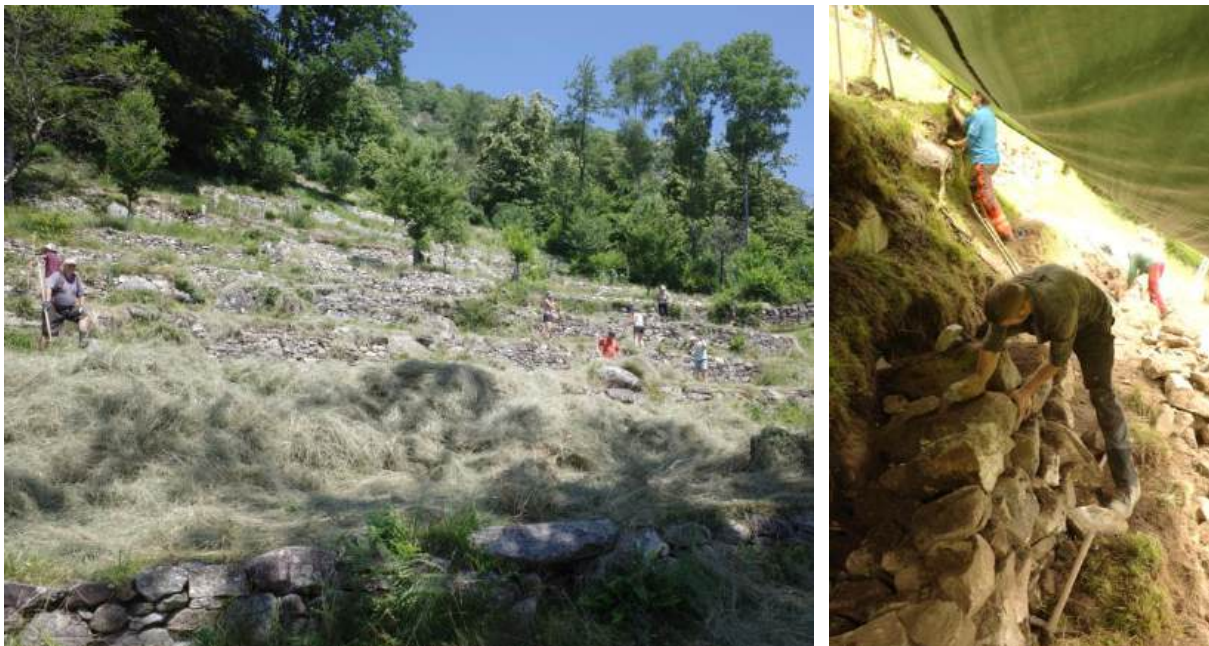
Heuet in der Campeggia dressa-Terrasse. Sanierung einer Trockenmauer (Fotos U. Nüesch).
